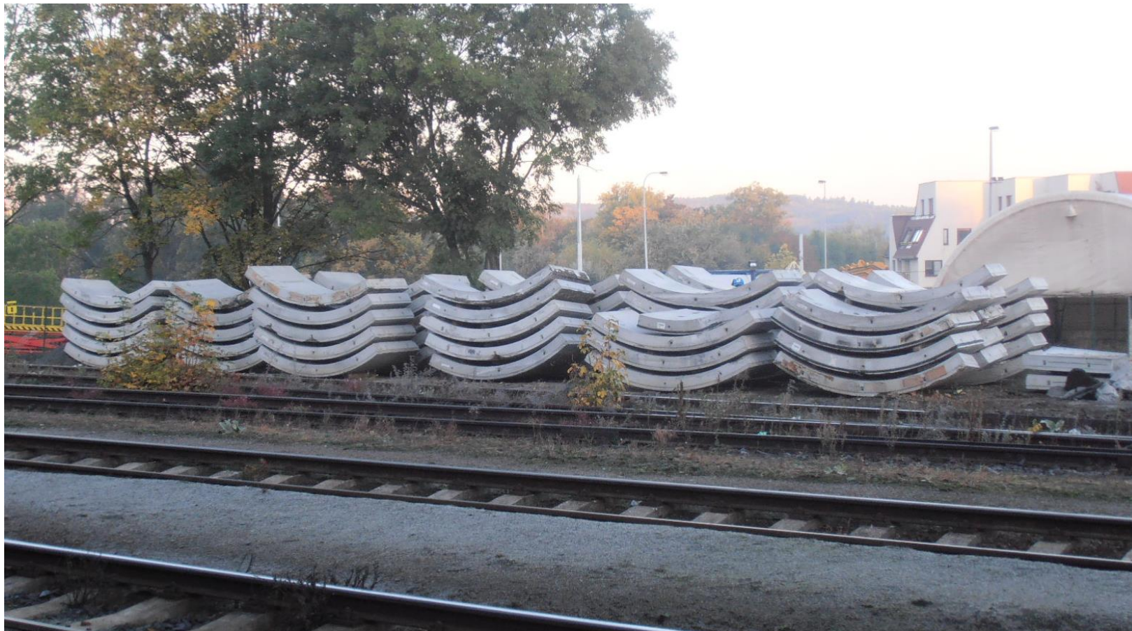
Ostění tunelu metra, Praha (Czech)
