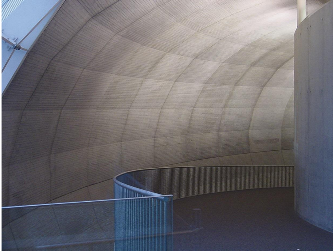
Ostění tunelu, Brno (Czech)
